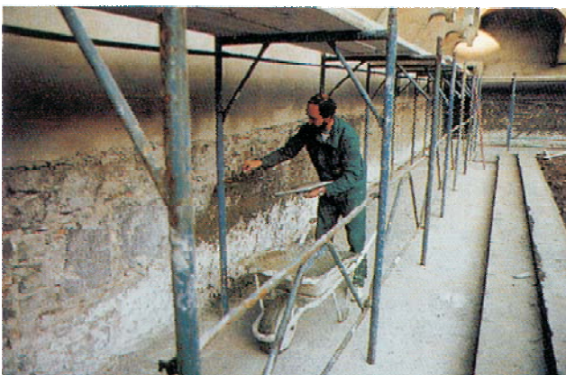
Spritzbewurf mit NEOPLAST LATEX
