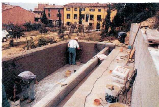
Schwimmbadabdichtung mit ANTOL AQUAPROOF und NEOPLAST LATEX
