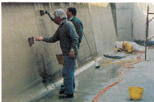
Kanalabdichtung mit ANTOL AQUAPROOF und NEOPLAST LATEX
