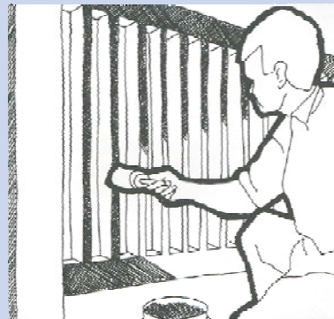
Schutz von Metallgeländern
