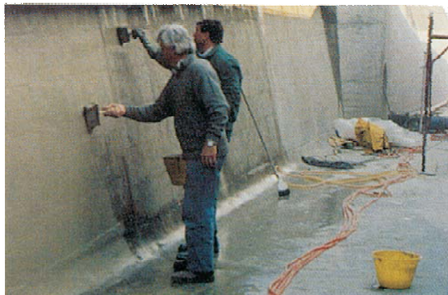
Impermeabilizzazione di canale con ANTOL AQUAPROOF al NEOPLAST LATEX
