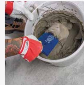
**3** Den Kleber mit einer Zahnpachtel, deren Zahnung auf die Art und die Maße der Fliesen abgestimmt ist, auf den Untergrund auftragen.
