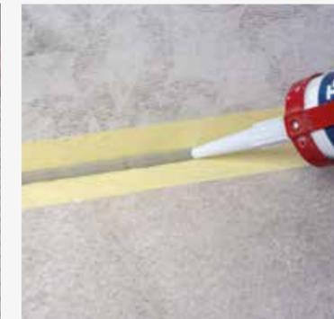
**6** Sobald der zementäre Klebermörtel trocken und ausgehärtet ist, Fugen mit Zement- und/oder Epoxidfugenmörtel füllen und diese mit einem elastischen Silikon-Dichtstoff abdichten.
