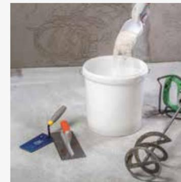
**3** Den Kleber mit einer Zahnpachtel, deren Zahnung auf die Art und die Maße der Fliesen abgestimmt ist, auf den Untergrund auftragen. Es sollte immer das „Buttering-Floating-Verfahren“ angewandt werden.
