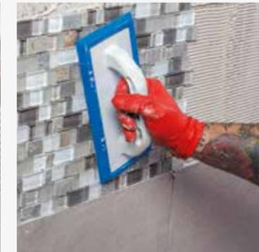
**6** Sobald der zementäre Klebemörtel trocken und ausgehärtet ist, Fugen mit Zement- und/oder Epoxidfugenmörtel füllen.
