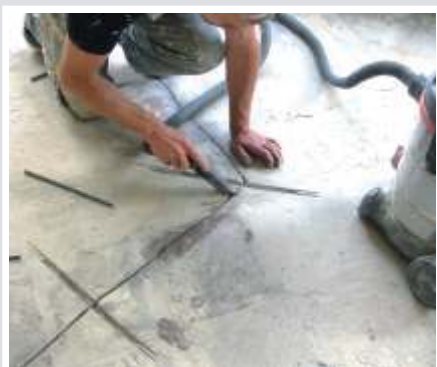
poszerzenie rys, wykonanie nacięcia prostokątnego w celu wklejenia zbrojenia, odpylenie
