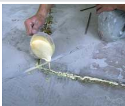
wypełnienie rys i nacięć żywicą
