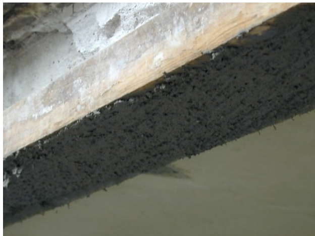
Oczekiwanie na wstępne stwardnienie zaprawy naprawczej
