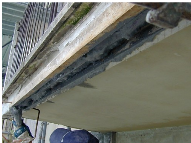
Montaż szalunku do wypełniania zaprawą naprawczą
