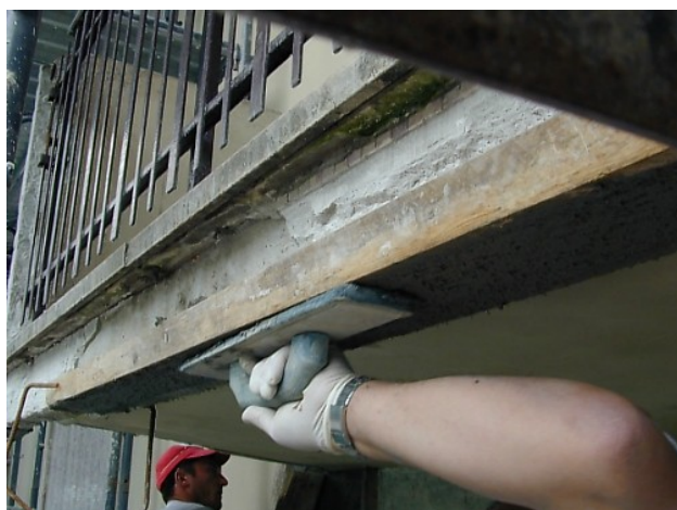
Zacieranie wygładzające zaprawy naprawczej
