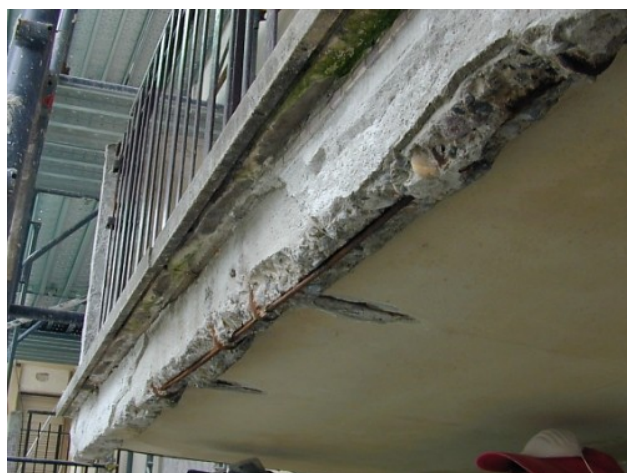
Widok zniszczonego okapu balkonu
