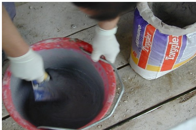
Przygotowanie zaprawy naprawczej typu PCC - ACS RESTAURO – (mieszanie ręczne małych porcji ,większe ilości przygotowywać z użyciem mieszadła wolnoobrotowego)
