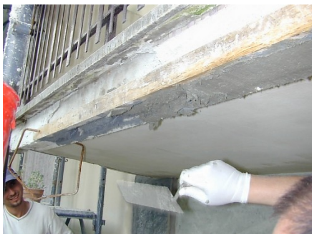
Wypełnianie szalunku zaprawą naprawczą ACS RESTAURO
