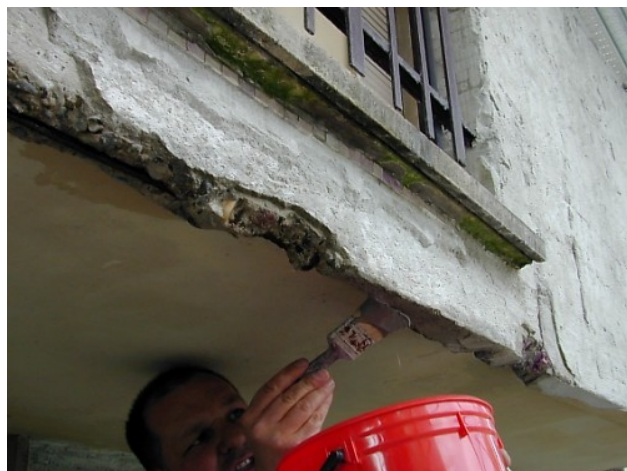
Zabezpieczenie zbrojenia preparatem antykorozyjnym ACS FERRI 1K .
