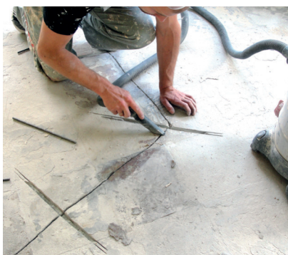
poszerzenie rys, wykonanie nacięcia prostopadłego w celu wklejenia zbrojenia, odpylanie
