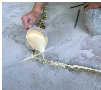
wypełnienie rys i nacięć żywicą
