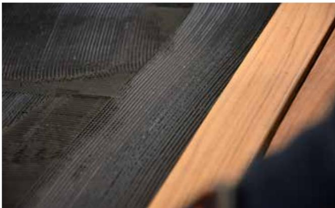
Preparare le superfici dove verrà incollata la coperta, siano lisce o porose e di qualsiasi natura, in modo che risultino pulite, sgrassate e compatte. Per l'incollaggio delle doghe in teck, applicare l'adesivo a strato sottile e letto pieno, con idonea spatola dentata, ed incollare prima della filmazione. Per l'incollaggio la temperatura di applicazione dovrebbe essere compresa fra 5 e 30° C.
