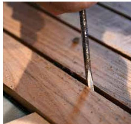
Nel caso di rifacimento di una vecchia sigillatura, rimuovere la vecchia gomma meccanicamente con l'ausilio di un cutter o con apposito utensile. Nel caso di nuova coperta, eliminare l'eccedenza dell'adesivo presente nei comenti dopo l'incollaggio.
