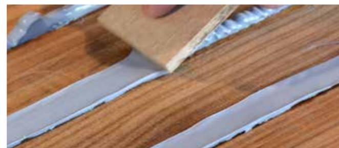
Immediatamente dopo l'applicazione, passare sul comento una spatola flessibile con un'angolazione di 30 gradi. Applicare una pressione sufficiente a fare in modo che la gomma penetri sul fondo del comento, ma lasciare uno strato di gomma in eccesso.
