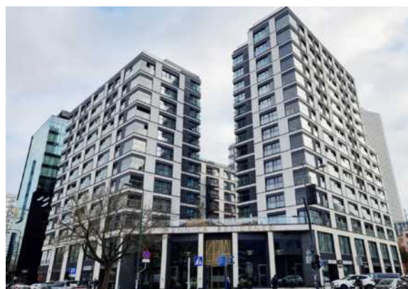
Mennica Residence w Warszawie
