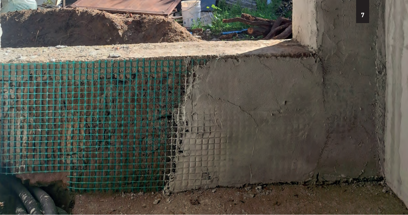
Componenti del sistema di rinforzo realizzato con intonaco armato (CRM) con matrice a base di calce idraulica naturale (NHL)
